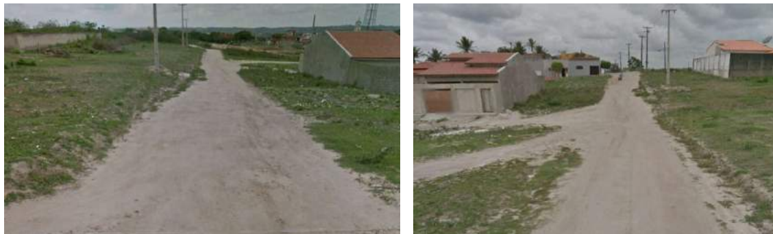
FOTOS 05 E 06: RUA ANTONIETA ALCOFORADO
