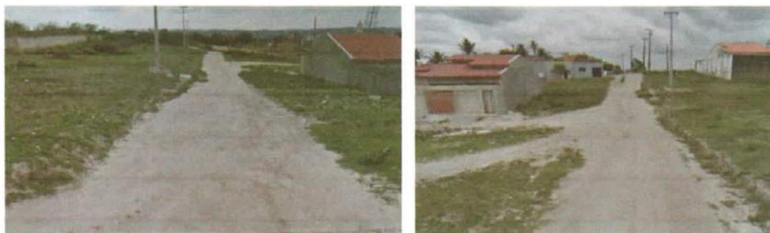
FOTOS 05 E 06: RUA ANTONIETA ALCOFORADO
